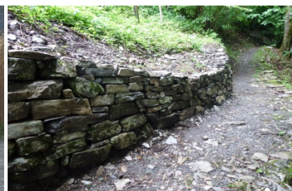
Sanierte Trockenmauer am alten Landweg in Bauen
