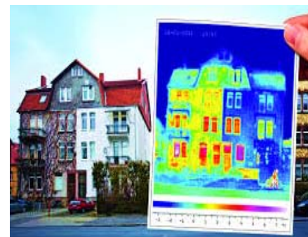
Beispiel Wärmebildaufnahme (Rechte Hausseite ist wärmegeämmt)
