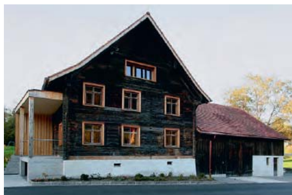
Gebäude nach der Sanierung
