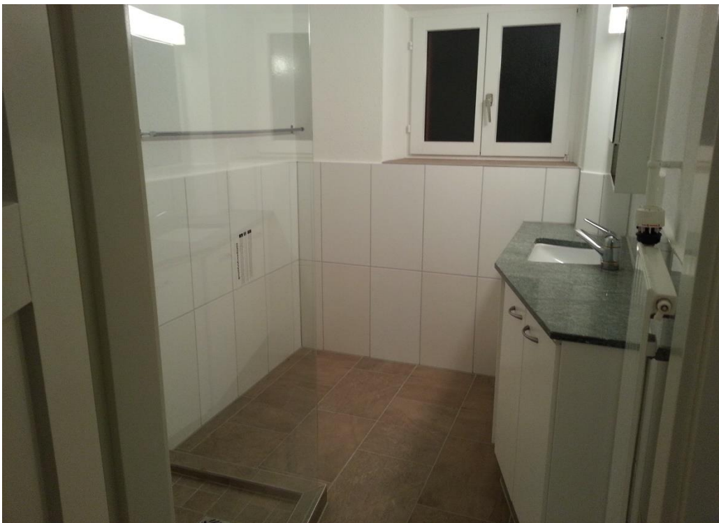
Dusche mit Einbaumöbel und Granit
